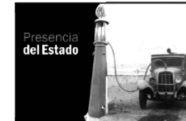
El surtidor de columna con luz en su cabecera señaló la presencia del Estado en lugares remotos.
