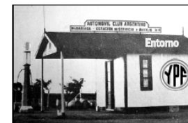
Se construyeron cientos de estaciones de servicio...
