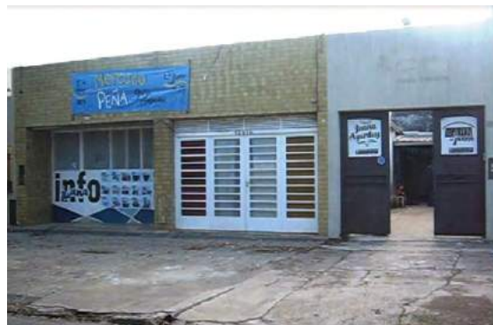
Fachada actual Espacio Cultural Juana Azurduy - calle 63 n°1261 entre 20 y 21
