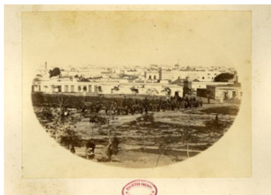
Vista de Buenos Aires tomada del Paseo de Martre (1864), Esteban Gonnet
