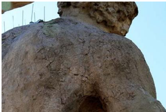
Figuras debajo. Hombro derecho. Fisuras múltiples combinadas
